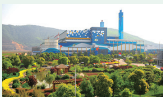
Suzhou Waste-to-energy Project 蘇州垃圾發電項目
