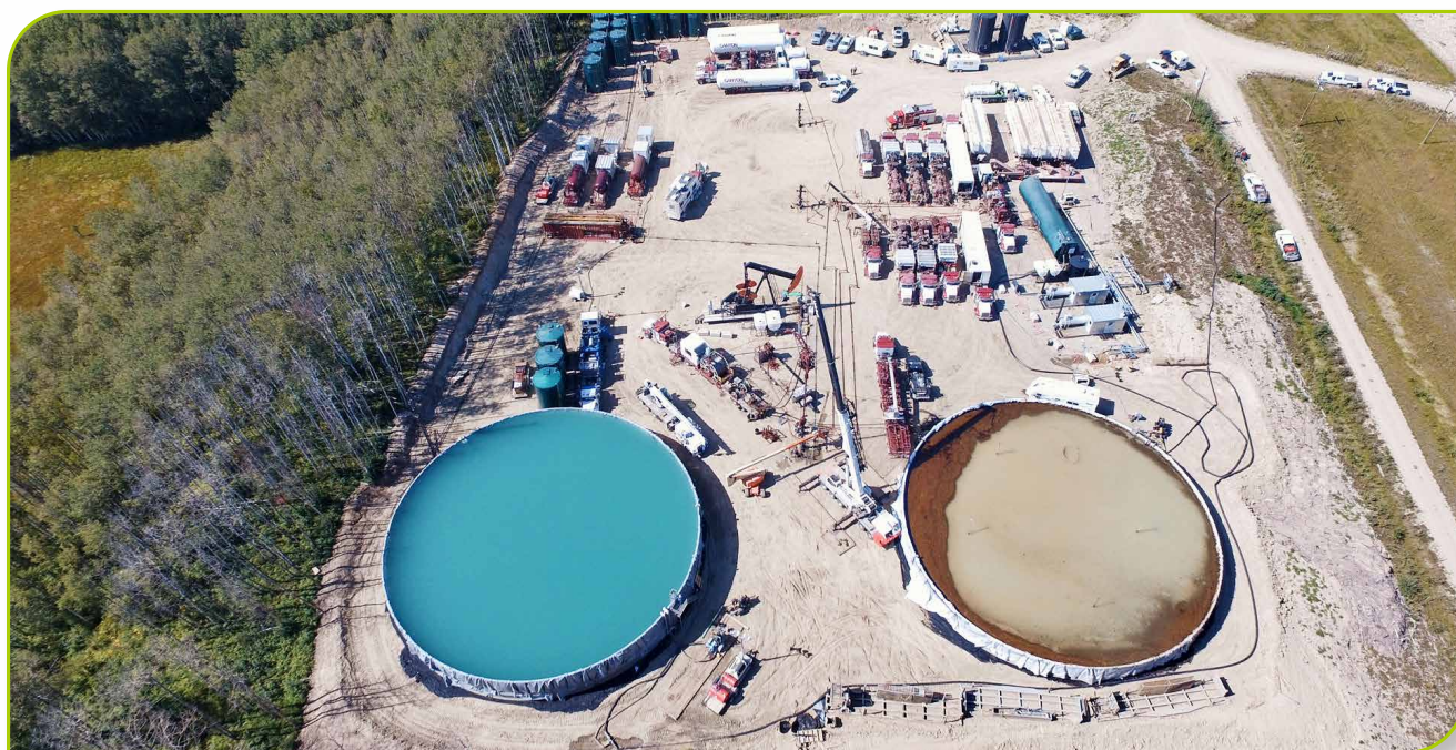
Recycling wastewater from hydraulic fracturing 對水力壓裂產生的廢水進行回收處理
