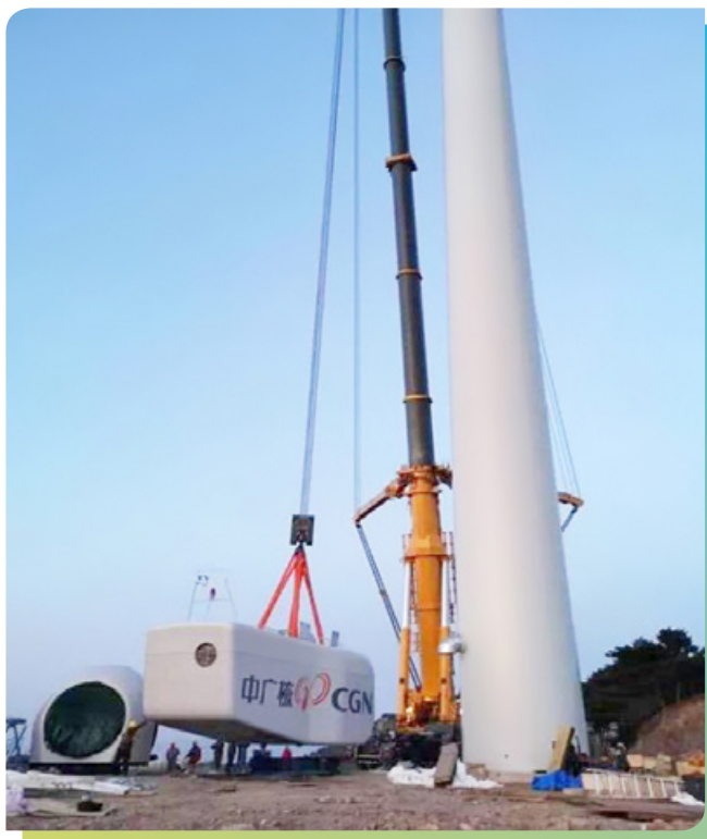
太谷范村風力發電項目風機吊裝工作現場
