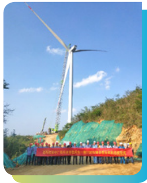
中廣核新能源受託管理的樂業扶貧風電項目工程現場
