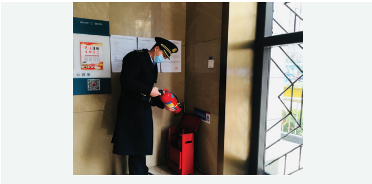
SCENE OF WINTER SAFETY INSPECTION 冬季安全大排查現場
