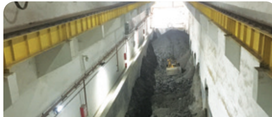
由焚燒爐排出的爐渣
