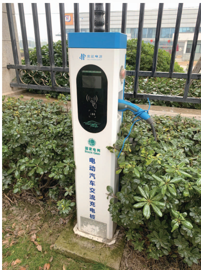
設置於天璽灣項目的電動汽車交流充電樁
