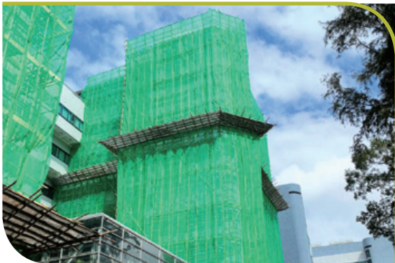
Façade repair works for campus buildings (2019-2022) for the City University of Hong Kong 香港城市大學校園樓宇外牆維修工程 (二零一九年至二零二二年)
