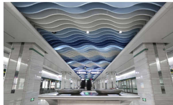
武汉市轨道交通6号线一期工程
