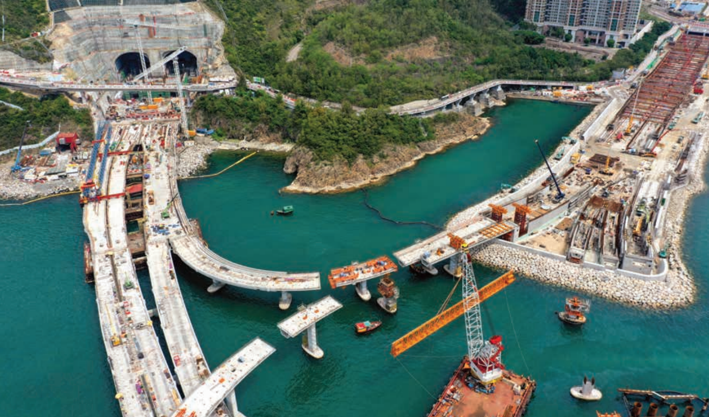
Tseung Kwan O — Lam Tin Tunnel — Tseung Kwan O Interchange and Associated Works 將軍澳 — 藍田隧道 — 將軍澳交匯處及相關工程
