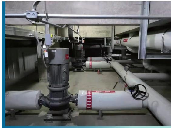
圖：車間淨化空調系統加熱系統
