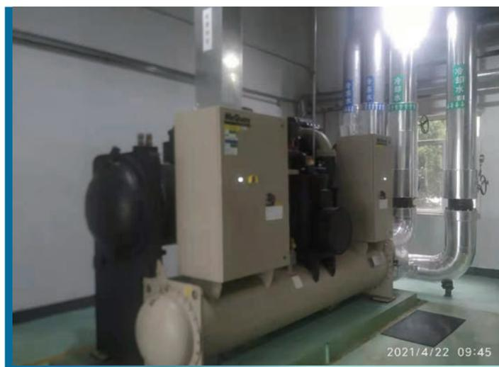
圖：冷凍站內製冷機組
