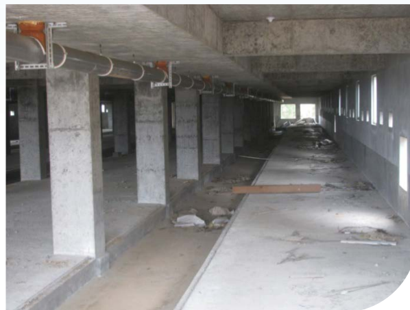
養豬欄內排水渠結構
