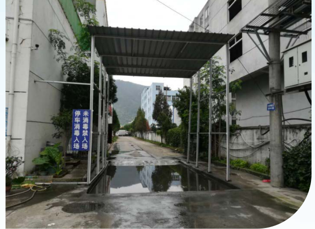
進入屠宰場的運料車的消毒水池
