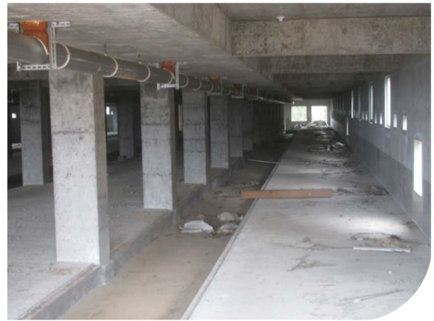
養豬欄內排水渠結構
