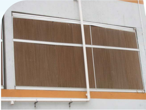
外牆開口處安裝蒸汽冷卻板
