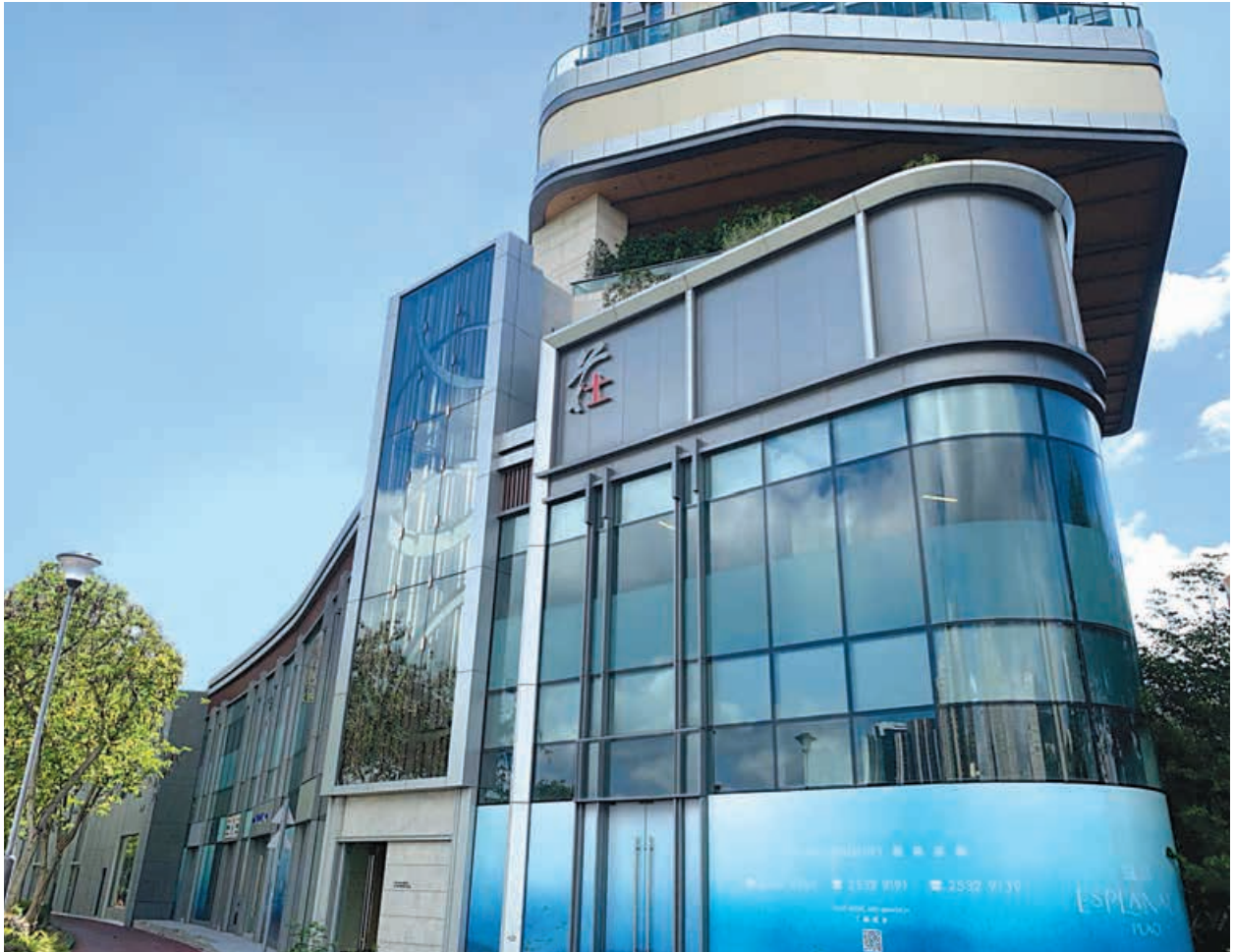
▲ 該照片攝於2021年6月3日，並已使用電腦影像技術進行編輯及處理。
