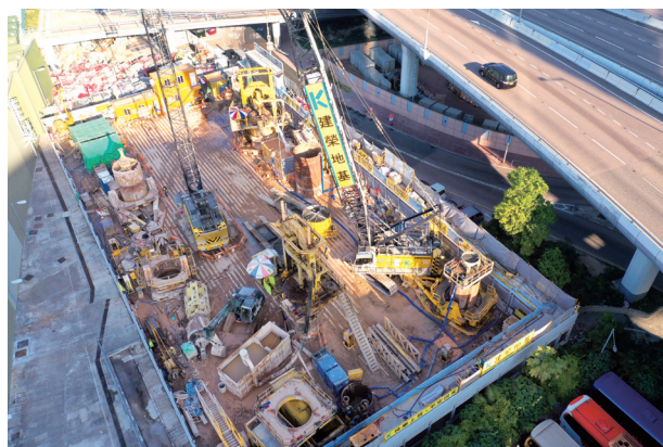
位於紅磡暢通道之地基打樁工程
