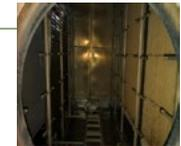
改造後，將原有加濕方式由水洗加濕改造為濕膜加濕，不需要運作噴淋水泵，從而實現節能 131,400 千瓦時。
