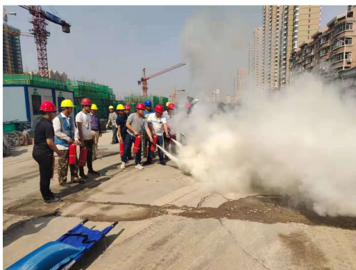
滅火器使用練習
