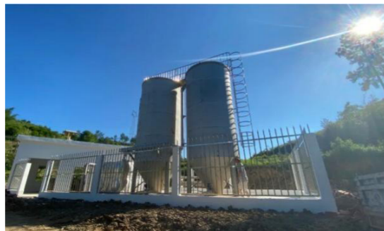
▲ 裡東沉澱池及泵房
