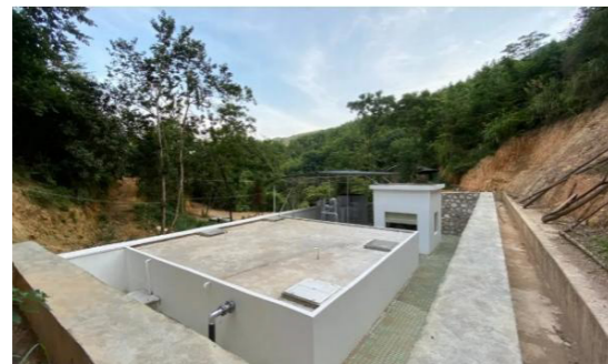
▲ 泰源蓄水池、管理房及一體化淨水設備
