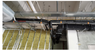
裝入岩棉板的隔牆
