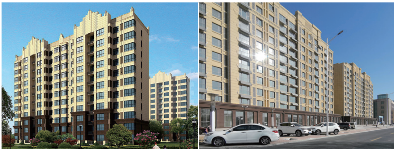
Yinchuan Project 銀川項目
