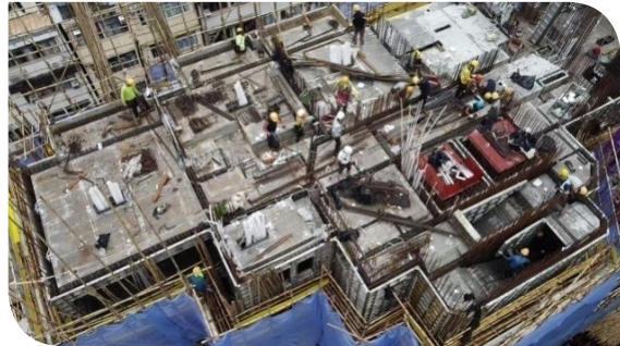
一般樓層建築使用鋁材模板，以減少使用木材
