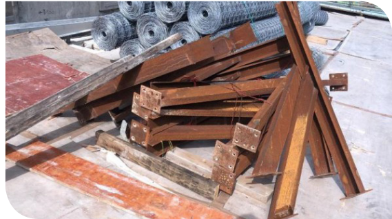
於建築地盤回收金屬再用
