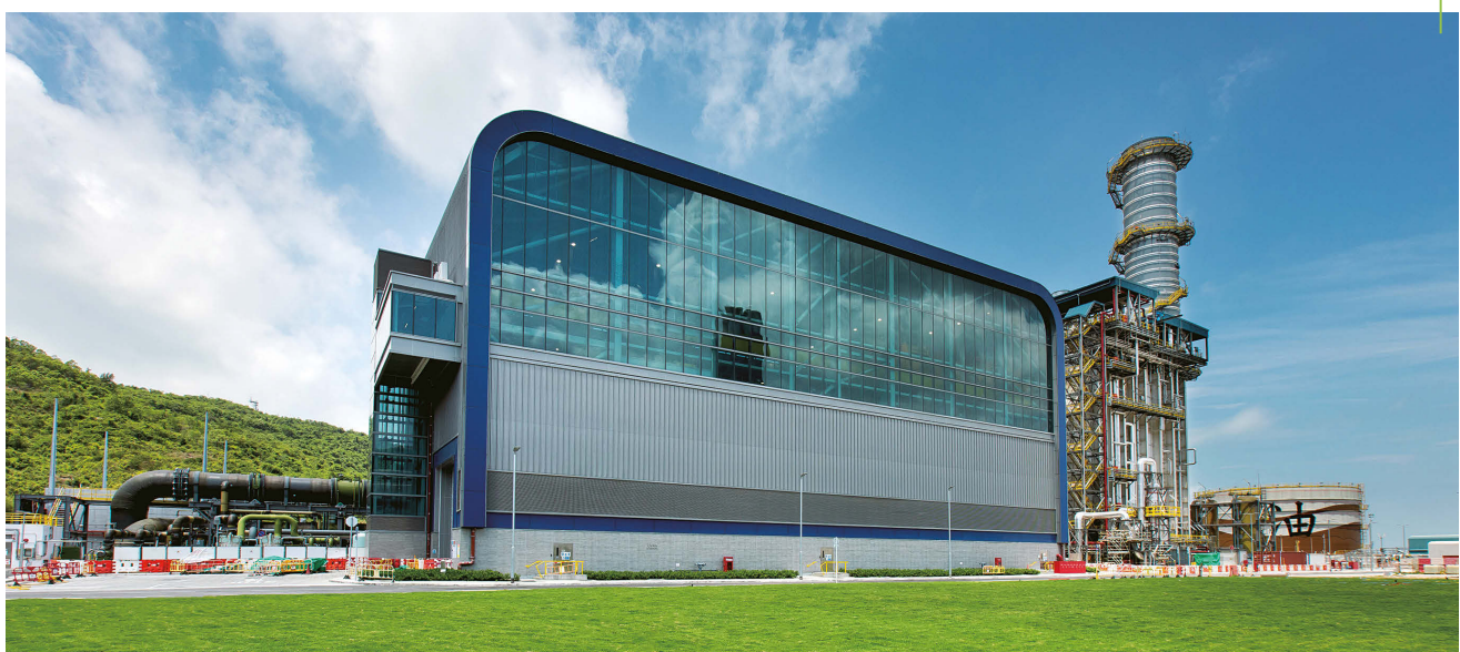
龍鼓灘發電廠新建的聯合循環燃氣渦輪機組於2020年投產，大幅降低中電發電的碳強度。
