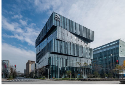
上海恒基旭輝中心 Shanghai Henderson CIFI Center
