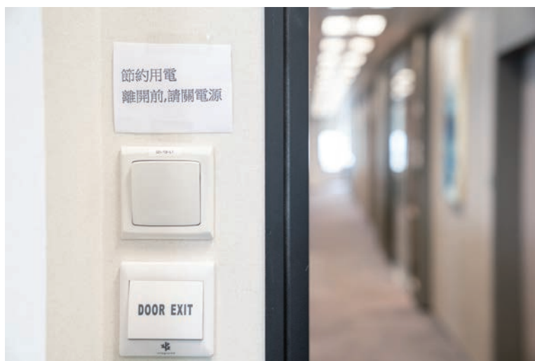
於燈掣及門掣開關旁邊張貼提醒節約能源的標誌
