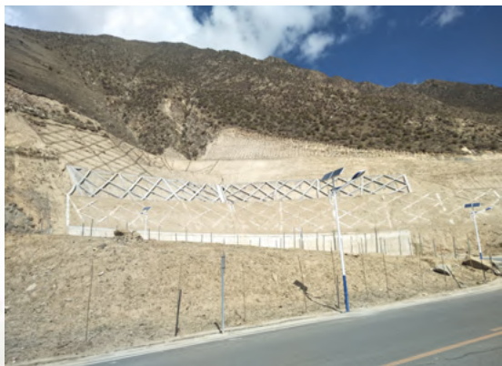
西藏巨龙矿山修复前
