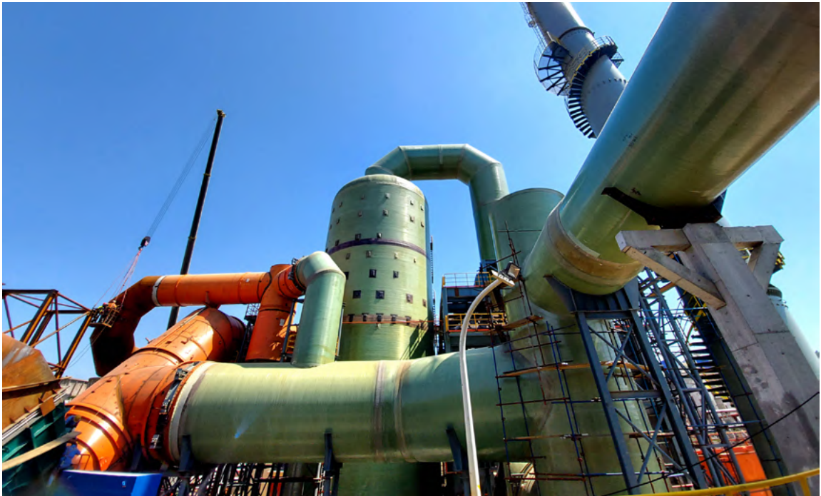
塞尔维亚紫金铜业 TIR 冶炼厂新建环集脱硫系统投入试运行
