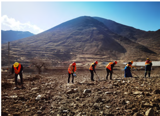
尾矿库下游生态修复前
