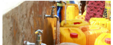
腾科和丰古鲁美两大城镇的取水点都连接到TFM建造的抽水站。丰古鲁美镇每天供应的饮水量达到约600立方。
