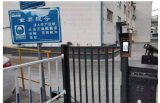
钼业选矿二公司在生产区域入口设置安全帽自动识别门禁系统，员工未佩戴安全帽门禁系统禁止通行。
