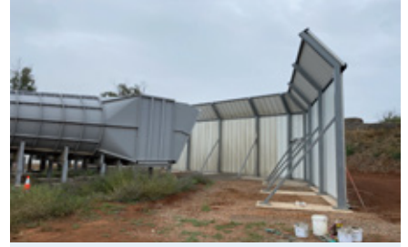
NPM矿区采用了一系列的降噪策略，其中最有效的是安装隔音墙。
