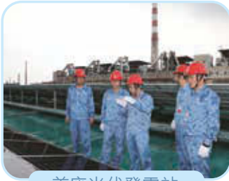
首座光伏發電站 並網發電
