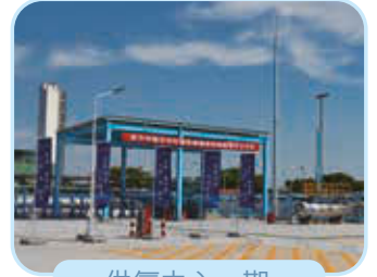
供氫中心一期 建成
