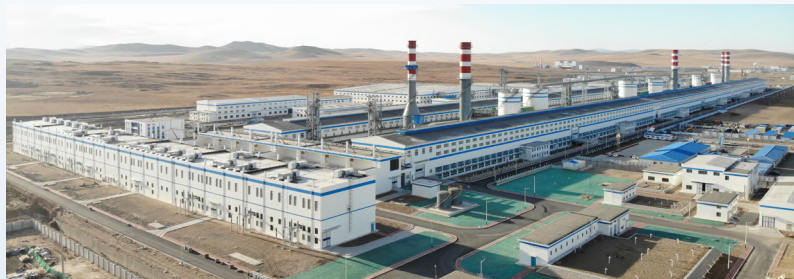
沈陽院總承包管理建設某公司高精鋁板帶產品項目壹期工程
