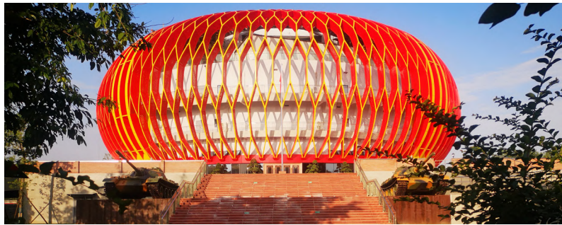
六冶建川博物館雙層鋁合金網殼專案主體工程完工
