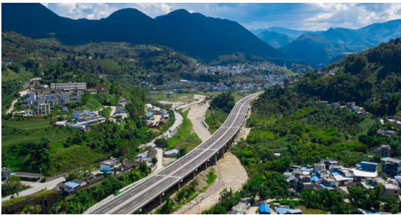
雲南高速公路項目現場
