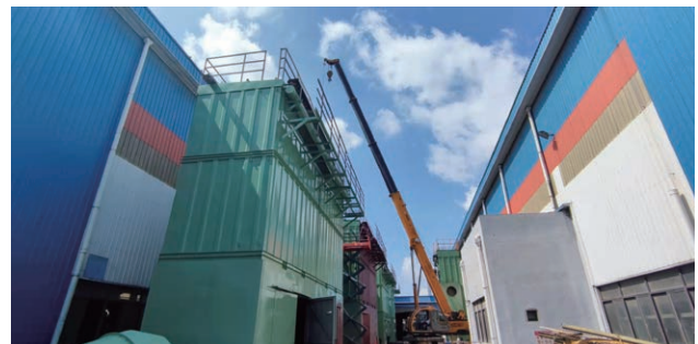
塗裝線油改水施工現場
