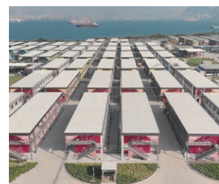
由中集模塊化建築承建的香港竹篙灣檢疫中心3A項目
