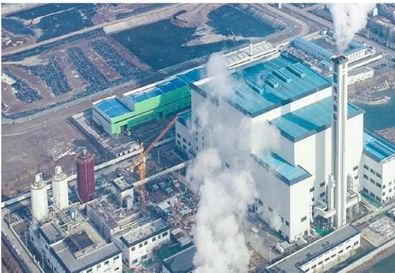
2021年，深高速廚餘垃圾處理流程實現升級改造，運用「水處理污泥+厭氧沼澤污泥+油脂分開處理+提高提油率+進厭氧罐+預處理+厭氧發酵+污水生化」處理工藝，迭代更新廚餘廢棄物「無害化、減量化、資源化」的三化要求，實現降低碳源使用量、節省運輸和營運成本。
