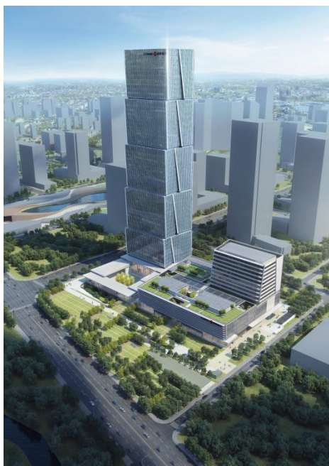
圖：錢江世紀城總部大樓項目幕牆採用雙中空玻璃進行系統設計，有效提高外牆節能性能。該項目獲美國綠色建築認證體系 LEED 金獎預認證
