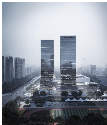
圖：西安科研中心項目包含集中太陽能熱水系統、雨水回收利用系統，太陽能熱水系統年預計提供熱水 6,108.69m 3 ，雨水回收利用系統回收及處理雨水將用於公共區域沖洗、綠化澆灌等，同時通過海綿城市設計，將屋頂及道路雨水引入場地綠化區域，控制雨水徑流及污染物，並對雨水再利用
