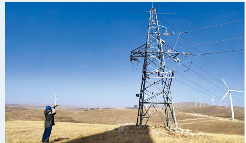
河北承德新能源事业部开展集电线路巡检保障供电
