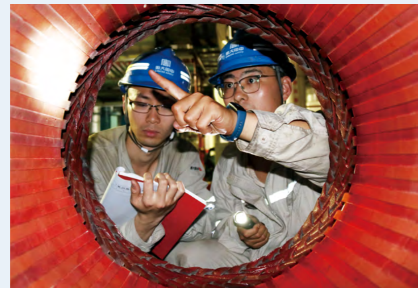
天津盘山发电公司完成自主检修
