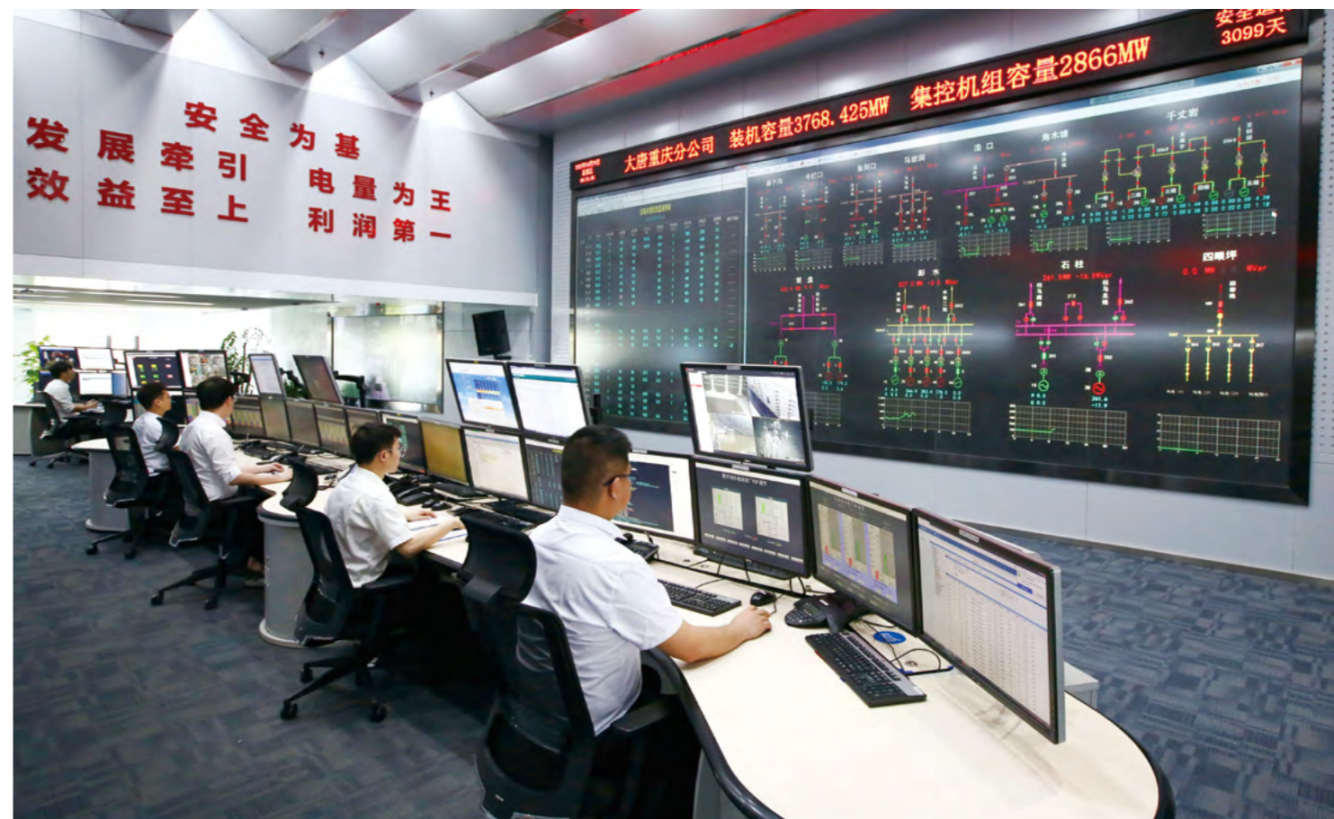
重庆分公司多能源集控中心控制大厅
