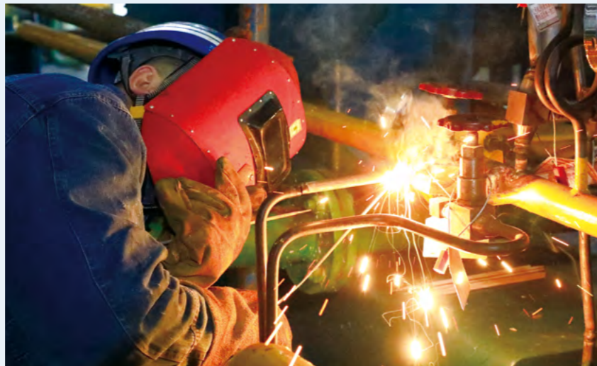
河北保定热电厂开展机组检修，全面排查设备隐患
