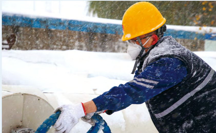
河北丰润热电公司风雪无阻保供热
