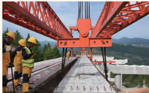
渝湘高速公路施工現場
