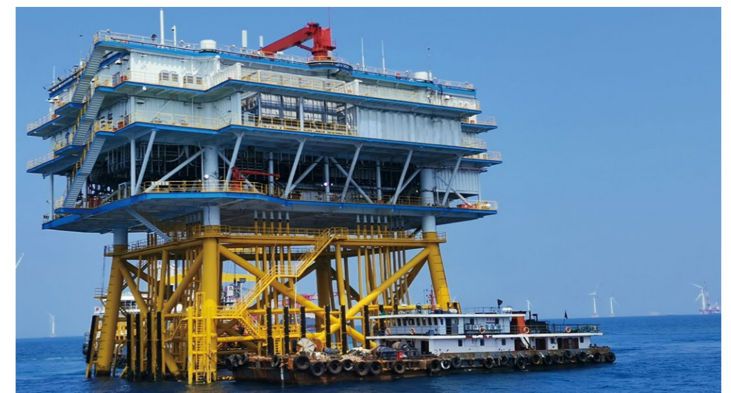
2021年12月25日，廣東省分行支持建設的我國首個百萬千瓦級海上風電項目——三峽陽江沙扒海上風電場實現全容量併網發電。
