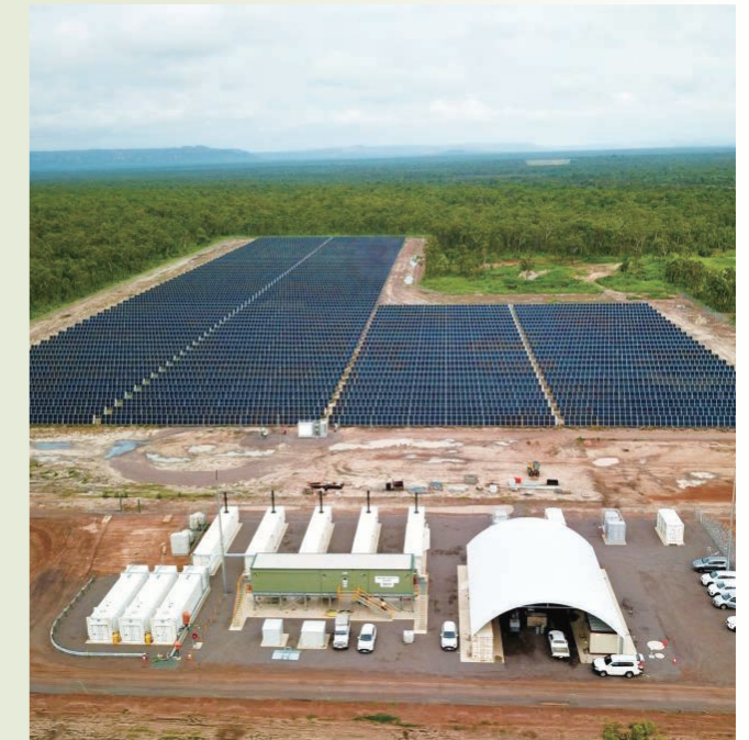
Jabiru 混合可再生能源項目的電池及柴油發電廠
