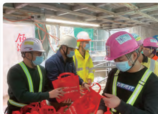
鼓勵承建商關愛及關顧工地工友，於節日派發禮品，促進工友及工地管理層雙向溝通。
