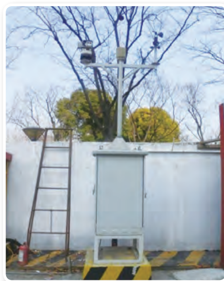
在建築地盤安裝分貝測量儀，監控噪音水準，每日進行數次隨機檢查，不定時記錄度數。
