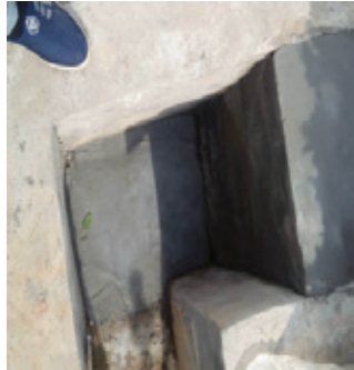
生產廢水排放進口封堵照片
