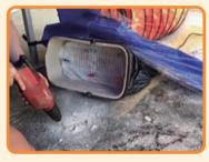
為防止於工程中產生的大量灰塵迅速擴散至周遭環境,影響居民健康及屋苑的空氣質素,我們「芊紅居團隊」設計了「無處有塵埃」,如大型真空吸塵器,不但有效覆蓋工作地點,阻隔灰塵飄散,並透過將工程中產生的塵埃即時抽入密封容器中,令員工免受灰塵佈滿全身之苦。這個發明容易安裝且可重覆使用,為我們的員工帶來方便及保持一個無灰塵的工作環境。
