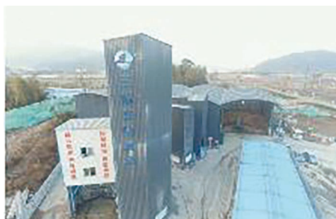
攪拌站全封閉
