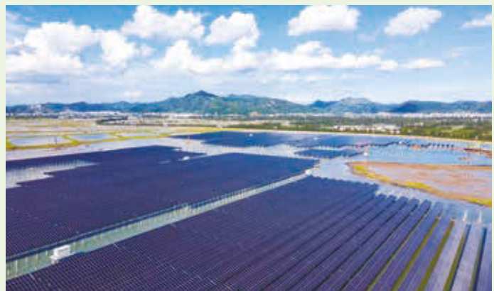
華能浙江清港光伏電站
