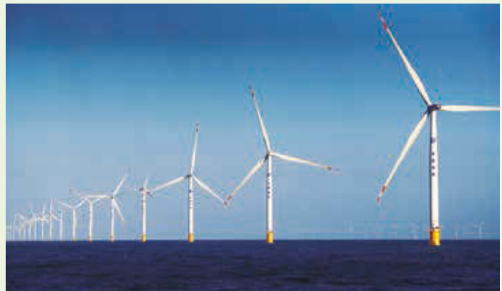
華能山東半島南4號海上風電項目
