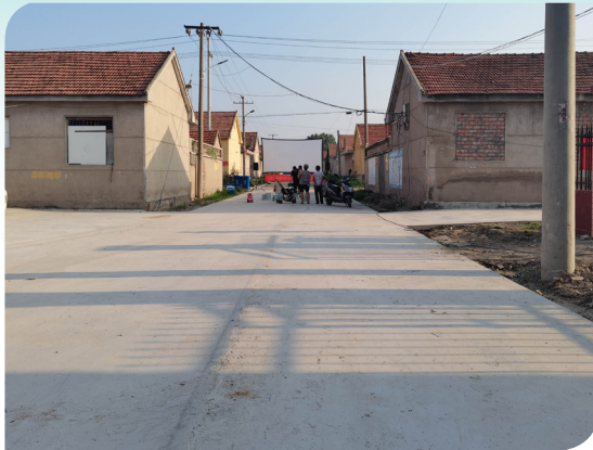
Photo: Wangjiadianzi Villager Service Plaza after the reconstruction 圖：經重鋪後的王家店子村民服務廣場
