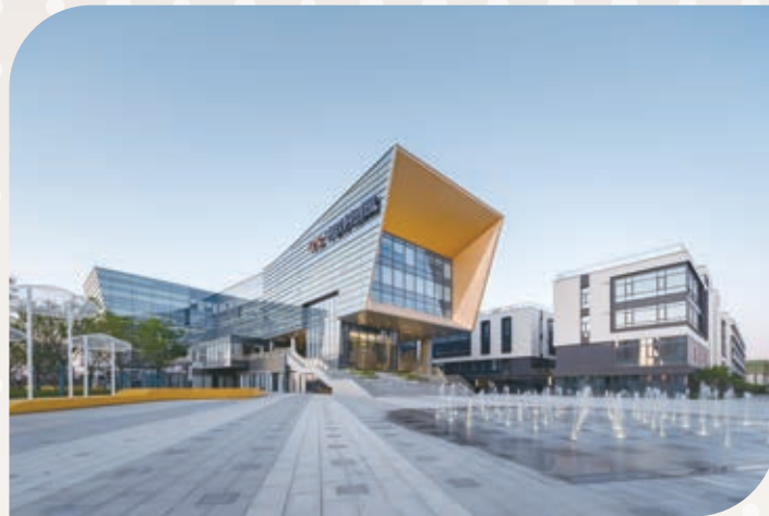
金茂中歐科創園成為全國首個完成BREEAM認證的產業園區
