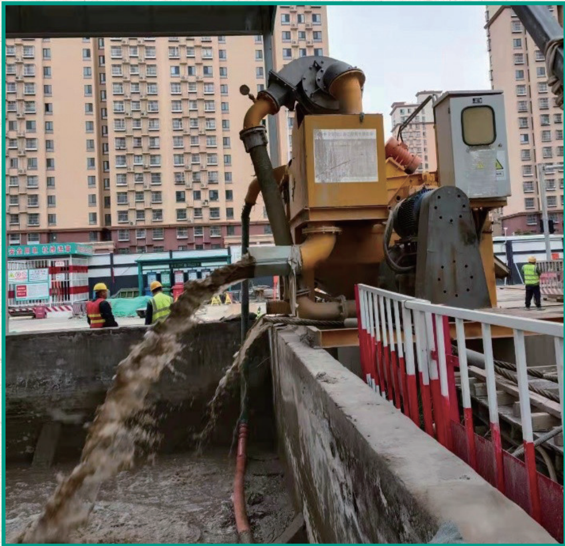
圖：泥漿分離機分離泥漿過程
