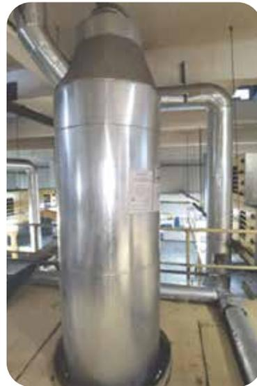
結合跨行業纏繞式換熱技術, 導入食品螺旋管式換熱器, 提高換熱效能, 節省蒸汽用量。該技術2021年在成都、瀋陽工廠導入應用, 節省蒸汽用量共約**550**噸; 減少二氧化碳排放量**163**噸。
