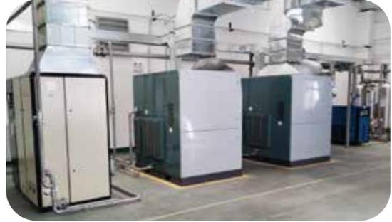
自主對各廠空壓機運行能效比檢測,制定改善方案並實施完成,主要改善措施:①檢視供氣壓損;②減少終端耗損;③夏季機房溫度優化;④漏點檢測等。2021年已完成21家工廠共計83台空壓機檢測及改善,節省用電量共約**1,231**兆瓦時;減少二氧化碳排放量**757**噸。
