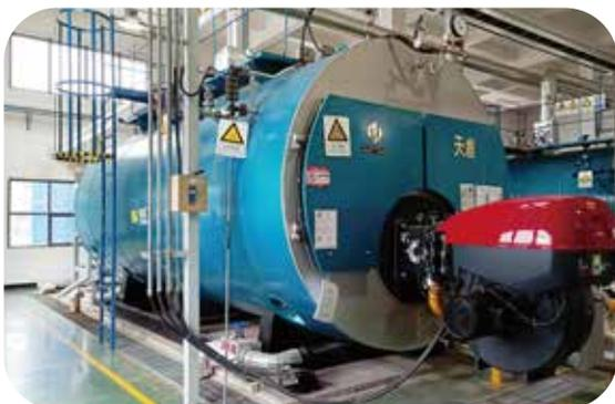
我們積極響應國家環保政策要求, 採取設備低氮改造、油煙淨化設備升級改造等系列措施, 有效實現大氣污染物減排。截至本匯報期末, 本集團已有陝西、北京、濟南等工廠共**38**台鍋爐低氮升級改造。
