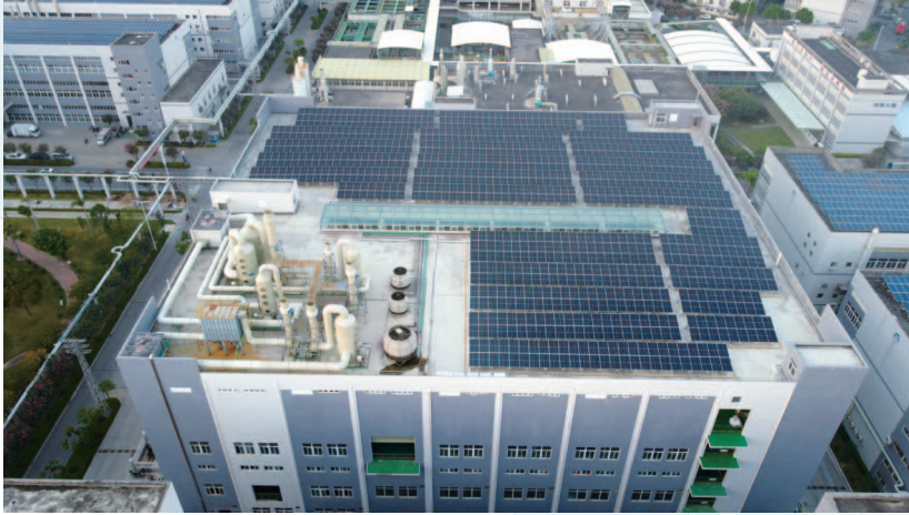
光伏發電設備
