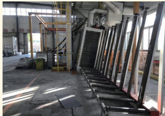
中集華駿磷化生產線改造為拋丸打砂線
