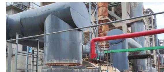
甯都贛鋒借鑒萬噸鋰鹽工廠的經驗，並通過對現有工藝分析，投資約 60 萬元新增一套餘熱鍋爐設施，將回轉窯窯頭廢氣熱量進行回收利用產蒸汽，現每天產氣約 20 噸，按 2021 年度蒸汽成本 205 元 / 噸計算，每月 26 天執行時間計算，一年節約成本約 127.9 萬元。
