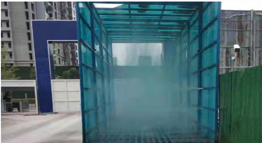
工地入口已安裝汽車清洗設備
