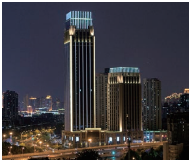
富豪新開門之寫字樓大樓 — 上蓋建築工程已竣工
