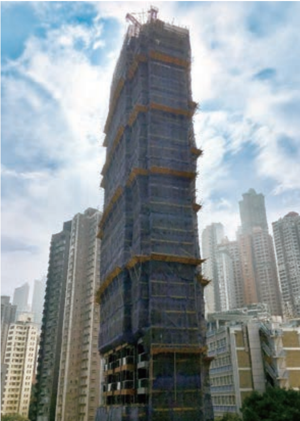
上蓋建築工程現正進行中
