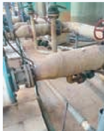
製作冷卻水回收管道
