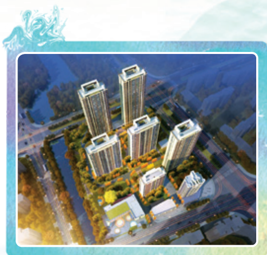
浙江省溫州市鹿城區E-25b地塊安置房項目
