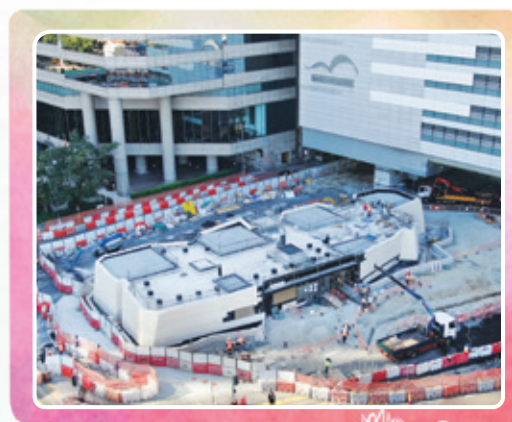
沙中線會展站及西面鐵路隧道 建造工程
