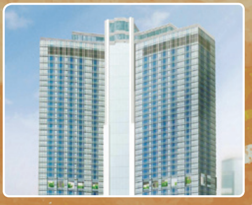
合和中心二期上蓋工程
