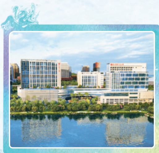
離島醫療綜合體 主體建造工程
