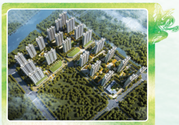
江蘇省鹽城市亭湖區長壩三期安置房項目
