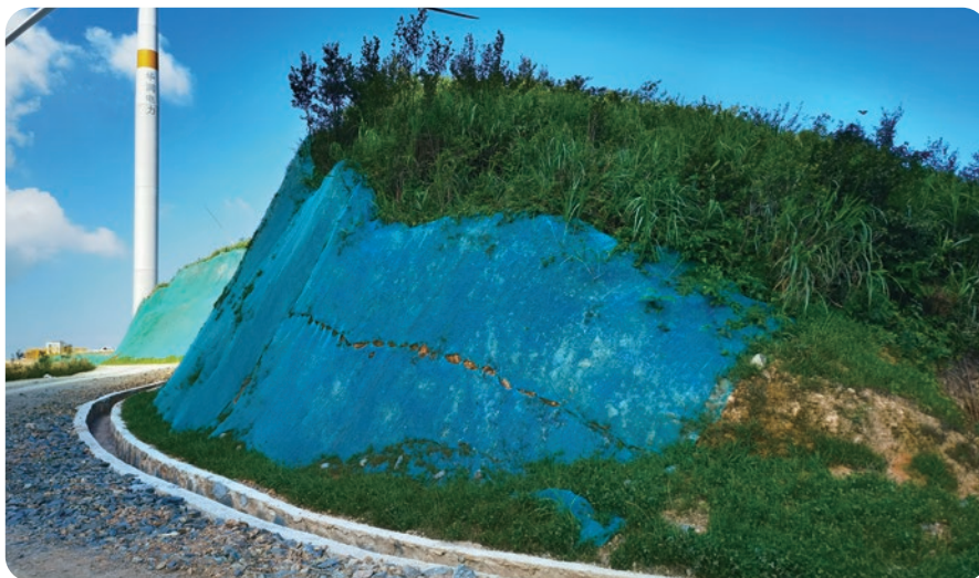
通过喷播草籽恢复风电场周边植被
