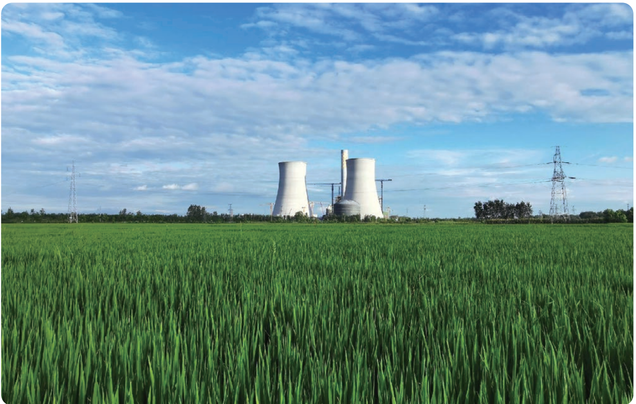
华润电力仙桃电厂
