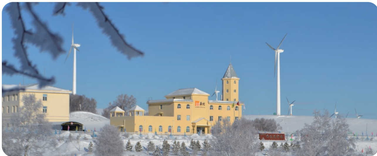
华润电力河北祥风风电场
