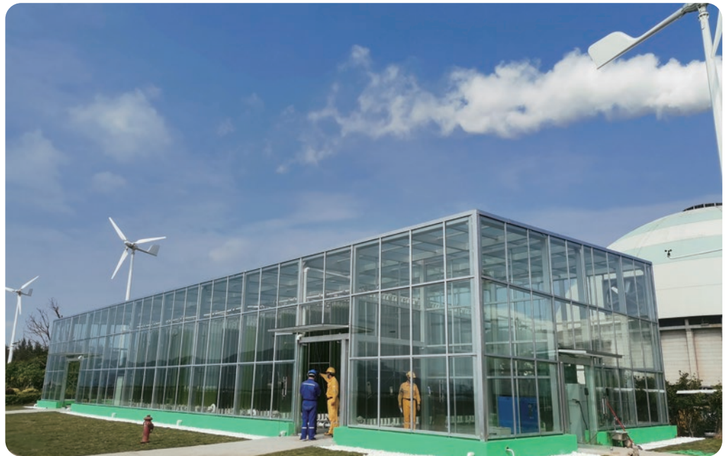
微藻固碳项目阳光房
