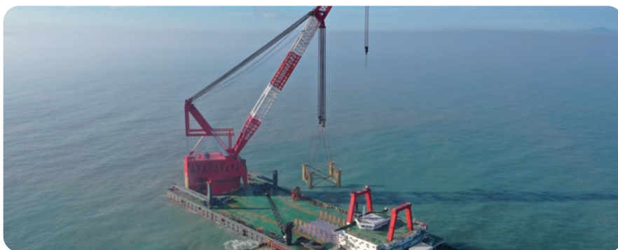
苍南1号基础施工定位平台作业
